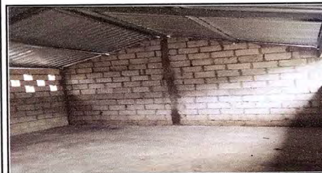
Foto 5: Vista al interior de la cocina trabajo finalizado
