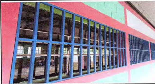
Foto1: Vista de colocación de balcones finalizada
