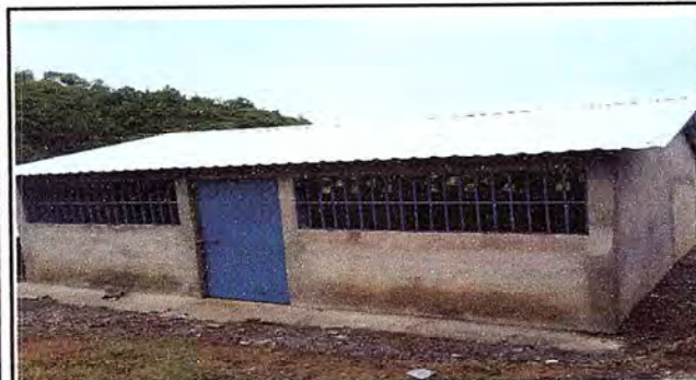
Foto 3: Trabajo finalizada reparación de cocina
