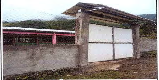
Foto 2: Vista de reparación del portón de la entrada principal y reparación de muro perimetral
