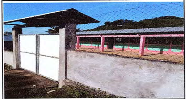
Foto 4: Trabajo finalizado reparación del muro perimetral
