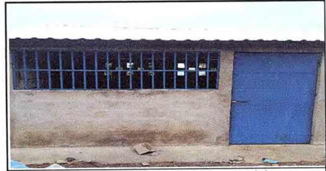
Foto 6: Vista de la cocina al frente, sustitución de puerta y balcones
